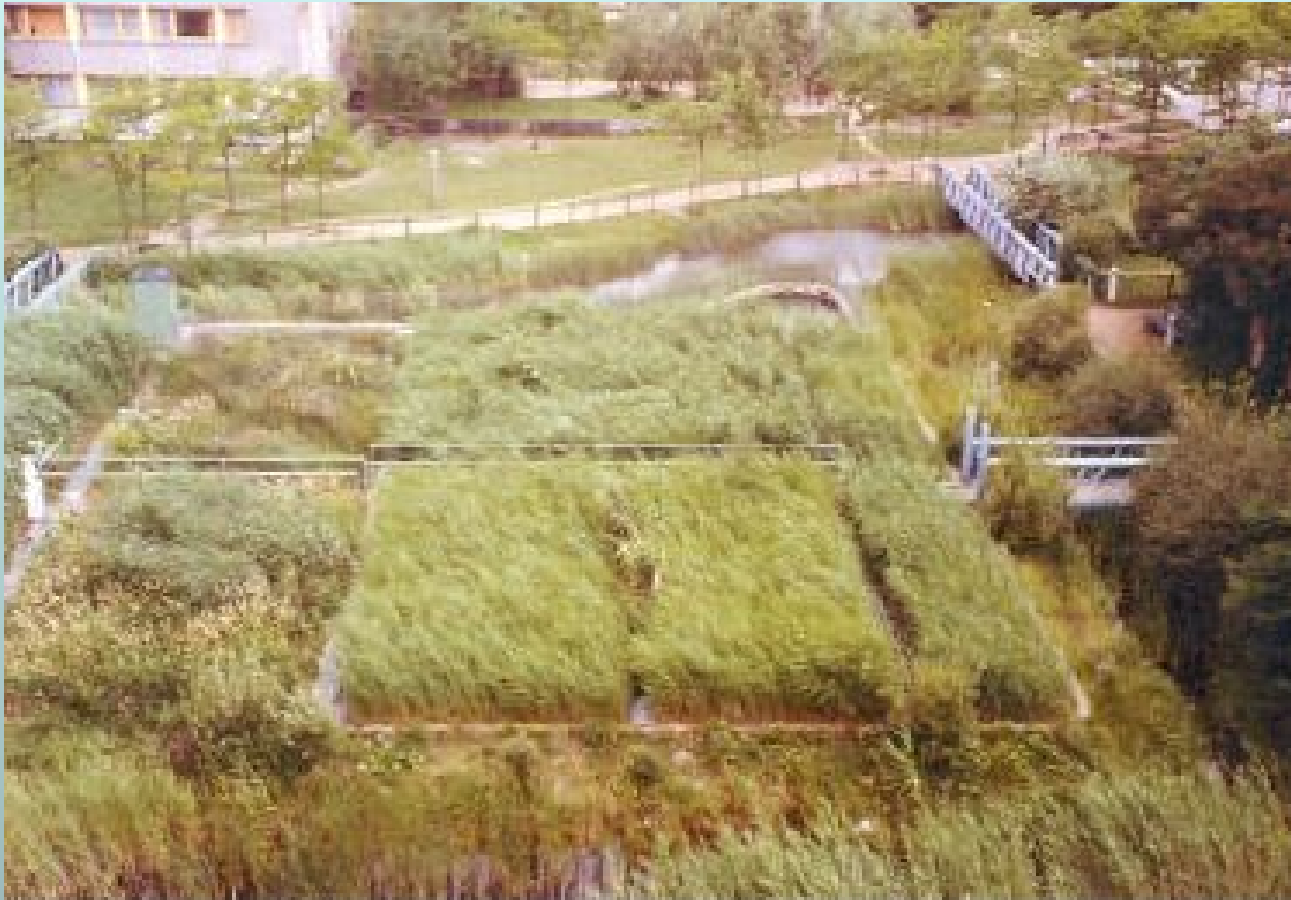
Sistema di fitodepurazione HF per le acque grigie
